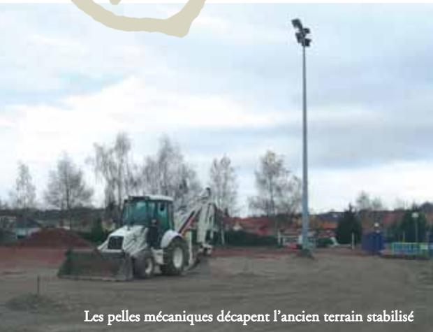
Les pelles mécaniques décapent l'ancien terrain stabilisé
