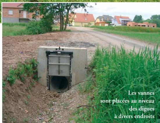
Les vannes sont placées au niveau des digues à divers endroits
