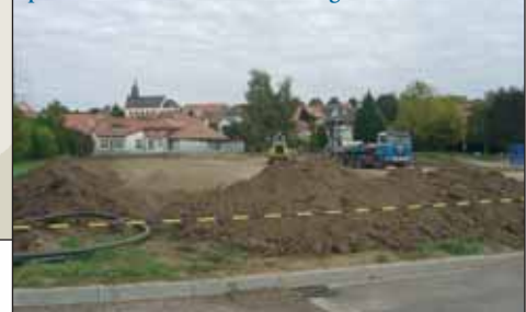
Fin septembre 2007 : la zone est décapée puis recouverte d'une couche de gravier
