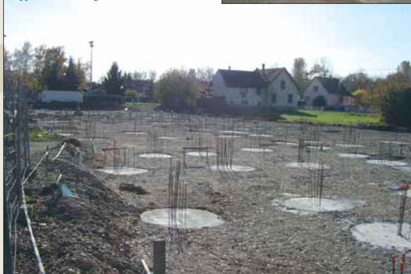
Début novembre 2007 : des puits de béton supporteront les longrines.
