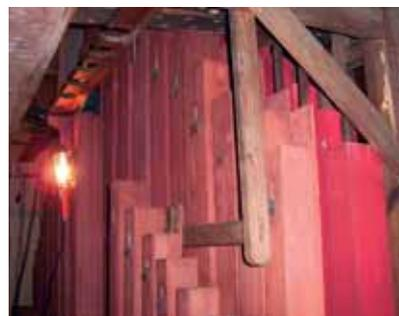
2. Restauration simple de l'orgue appelée travaux de relevage qui se décompose comme suit : Démontage, buffet, charpente, console, transmission, alimentation, sommiers, tuyauteries, Montage, harmonisation et accord pour un montant total de 21 229€.
