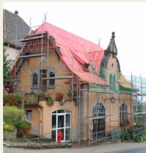
▲ Octobre 2013 : un échafaudage entoure le corps de garde pendant les travaux
