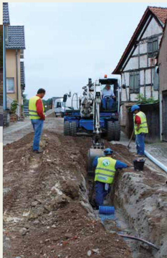
Août 2013 : la rue en plein chantier
