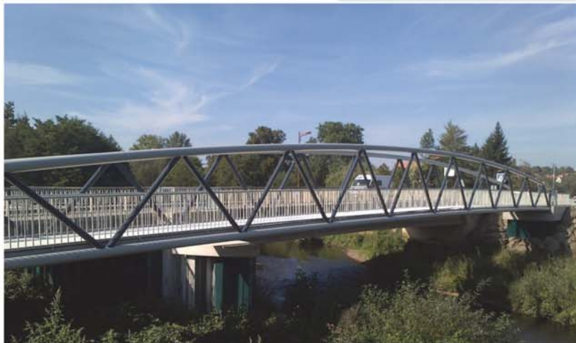
Passerelle d’Ernolsheim sur Bruche Architecte : EMCH + BERGER
