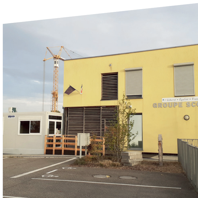
Les modules installés le temps des travaux d'agrandissement
