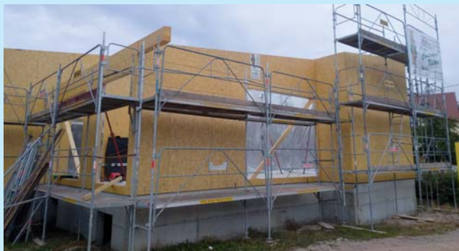
Les murs à ossature bois extérieurs sont quasiment terminés.
