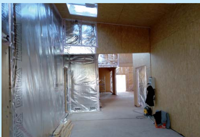
Les espaces intérieurs et les volumes sont déjà bien visibles.
