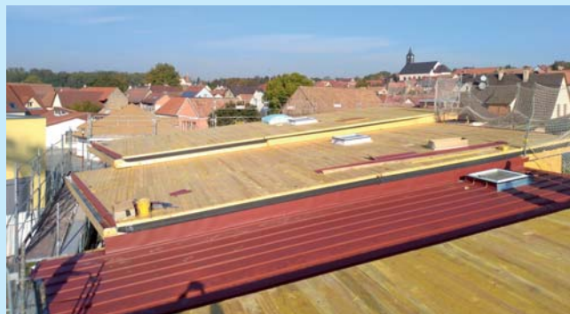
Vue de la toiture, constituée de panneaux à joints debout.
