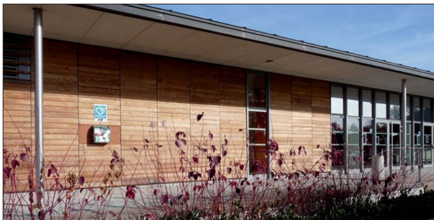
A Ernolsheim-Bruche, l'appareil, placé dans un coffret de protection, est situé sur la façade avant de la salle socioculturelle, et accessible 24h/24h.
