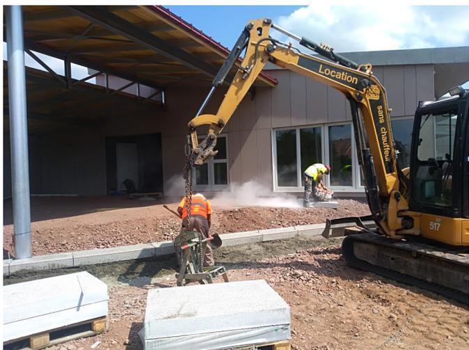
Après la pose des murs en L et l'accès PMR, préparation et pose des blocs marches pour l'accès au préau avant le pavage.
